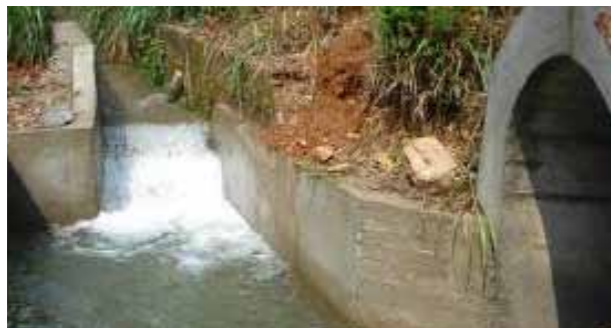
酸性水库截洪沟及巷道排水
